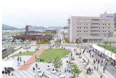
キャッセン大船渡エリア全景
