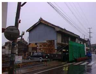
街路工事着手前の「いにしえ街道」
